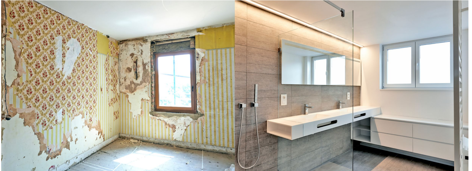
Bei Totalsanierungen und grösseren Umbauten empfiehlt es sich, die ausgeführten Arbeiten detailliert zu dokumentieren.
